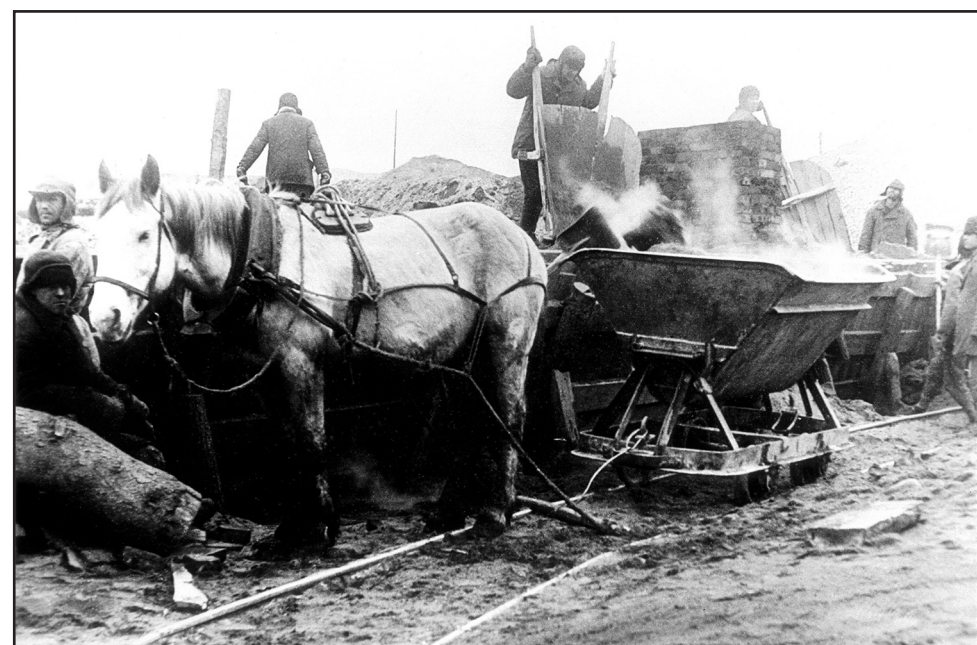
Конная тяга. Погрузка грунта в кочную вагонетку узкой колеи
