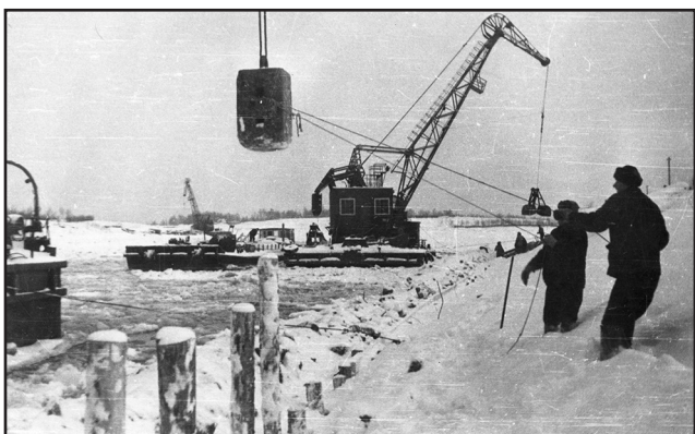
Ремонт откосов русла канала, 1960-е годы
