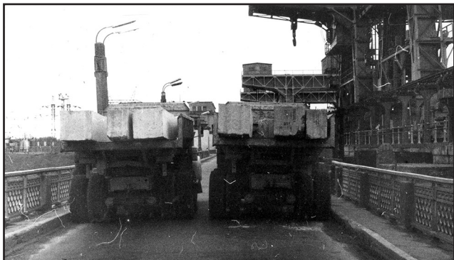
Испытание грузоподъемности моста плотины
